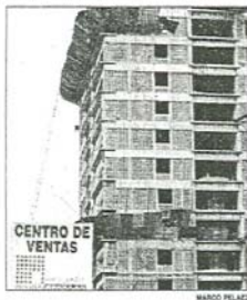
Construcción de una torre de departamentos en la colonia Anáhuac
