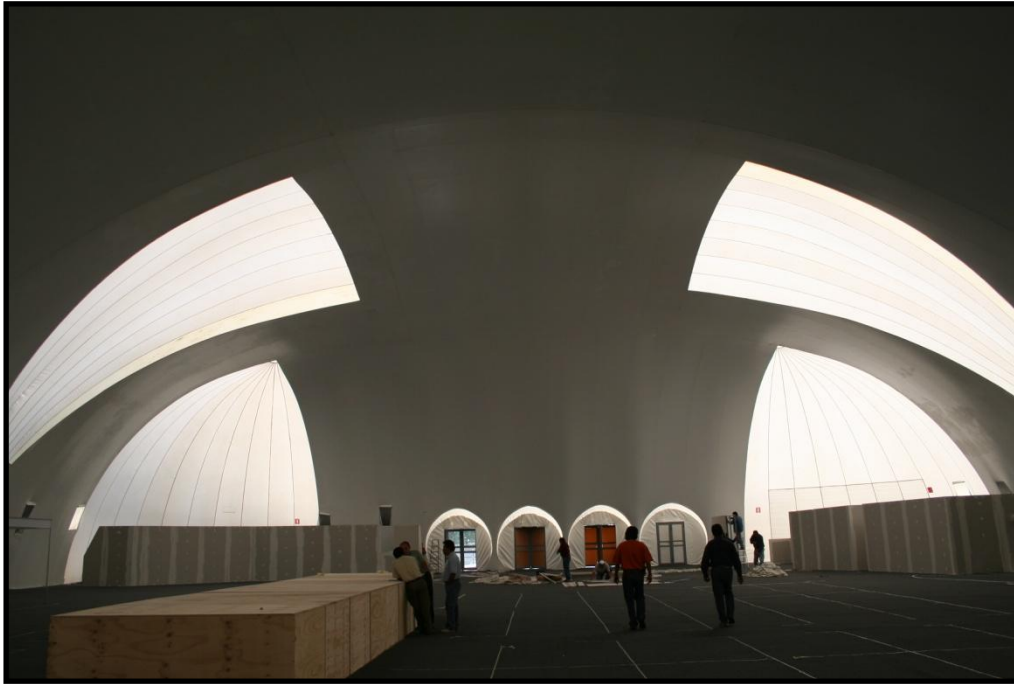
Imagen 13. La carpa neumática no contaba con estructuras fijas para soportar sus muros o techo.
