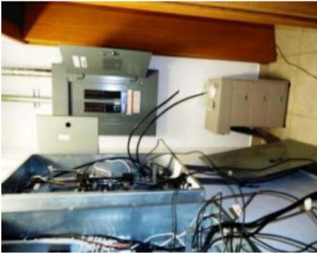
Acomodo de cables y colocación de interruptores en tableros
